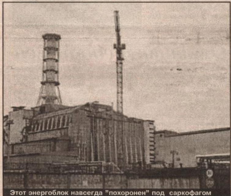
Этот энергоблок навсегда "похоронен" под саркофагом
